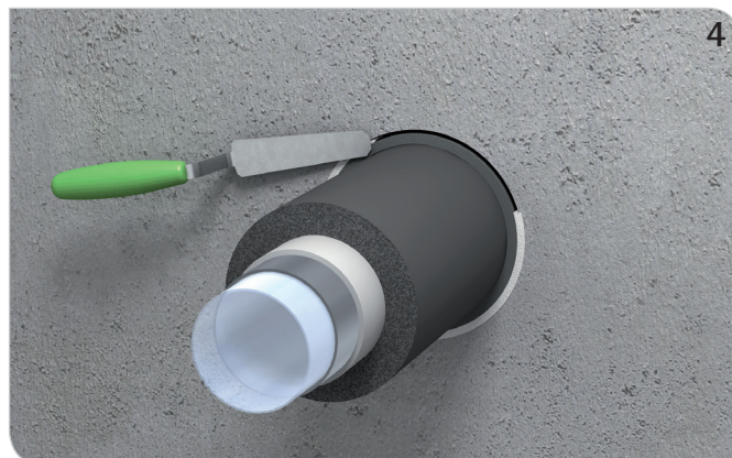
Rest- bzw. Ringspalt rauchgasdicht (mit z. B. Pacifyre® FPM Brandschutzmörtel) verschließen.
