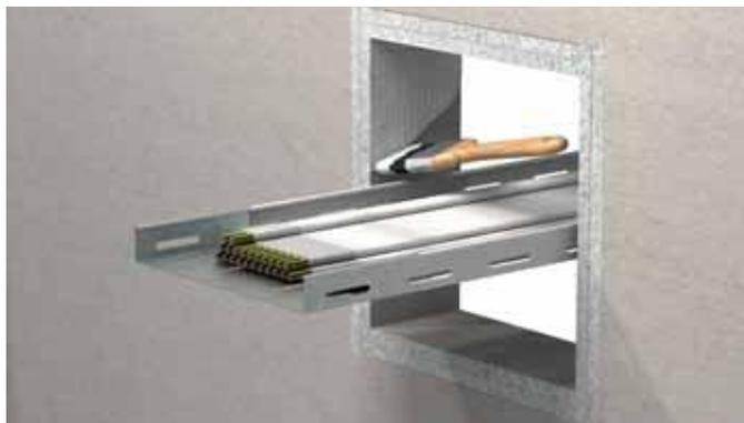
1. Vyčistíte otvor a odstránite prach a prípadné nečistoty. Na boky priestupu naneste protipožiarny náter.
