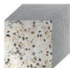
Beton (spękany i niespękany)
