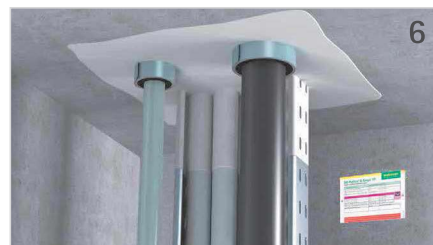
Kennzeichnungsschild ausfüllen und neben der Abschottung anbringen.
