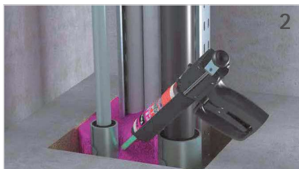
Tangit FP 550 Brandschutz-Schaum einbringen.
