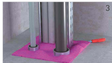
Falls gewünscht, überschüssigen Schaum abschneiden.
