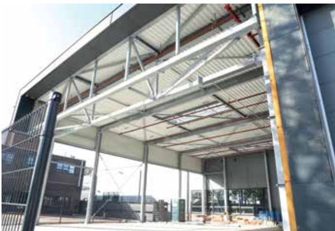
Muelle de carga para camiones - Países Bajos
