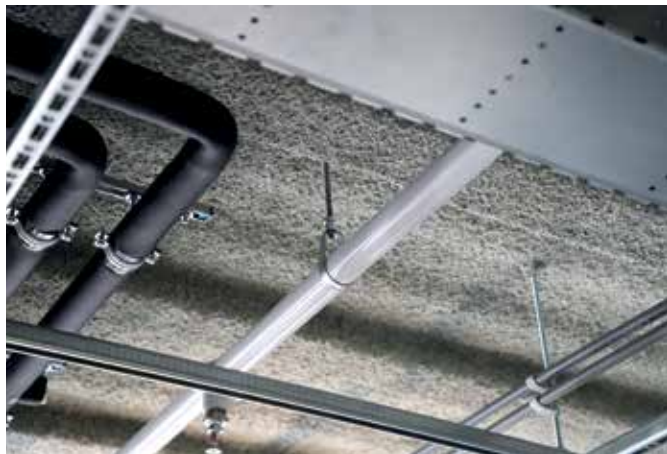
Budynek biurowy – Holandia
