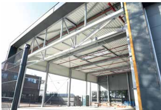
Rampa załadunkowa dla ciężarówek – Holandia
